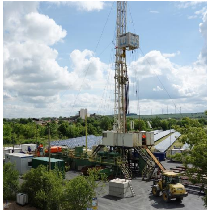
Das ist die Bohranlage im Norden von Erfurt, mit der ein Forschungsteam aus Jena im Sommer 2013 eine Forschungsbohrung durchgeführt hat. Foto: Jan-Peter Kasper/Universität Jena
